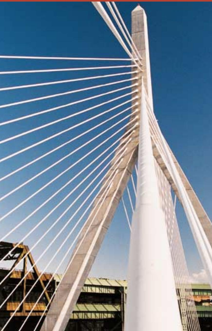
Le pont de la Charles River, à Boston, a été haubané par Freyssinet. Avec ses 56 m de large, un record mondial pour ce type d'ouvrage, il accueillera 10 voies pour permettre de fluidifier la circulation.
