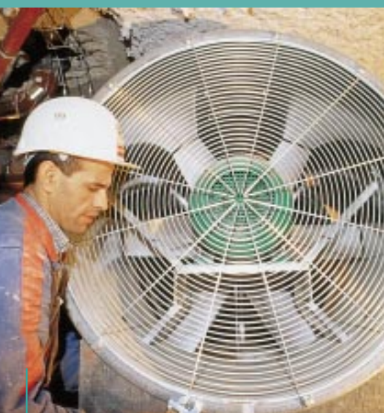
Illustration du savoir-faire de Sophiane en traitement de l'air : les équipements de désenfumage du nouveau centre de cardiologie de l'hôpital de la Pitié-Salpêtrière, à Paris.
