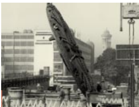
Après avoir conduit les travaux de génie civil de la ligne 2 du métro du Caire, Campenon Bernard SGE creuse deux tunnels routiers au tunnelier sous le quartier d'El Azhar, berceau historique de la capitale égyptienne.
