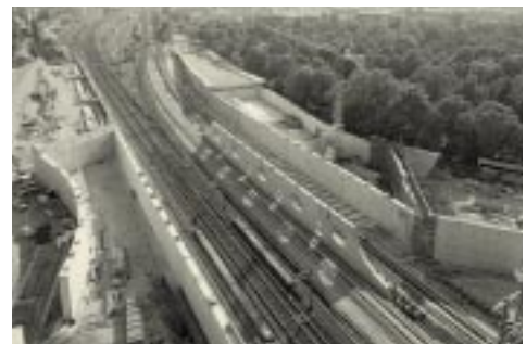
La construction du « pont de Berlin », qui enjambe une voie ferrée en exploitation, constitue le plus grand chantier réalisé à Leipzig dans le domaine des transports depuis la Seconde Guerre mondiale.
