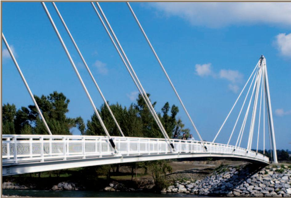
Die von Freyssinet entwickelten Schrägseile aus Kohlenstofffasern, die erstmals beim Bau der Fußgängerbrücke in Laroire (Frankreich) zum Einsatz kamen, verlängern die Standzeit des Brückenüberbaus. Dafür erhielt Freyssinet 2003 den Hauptpreis beim Innovationswettbewerb des französischen Tiefbauverbands.
