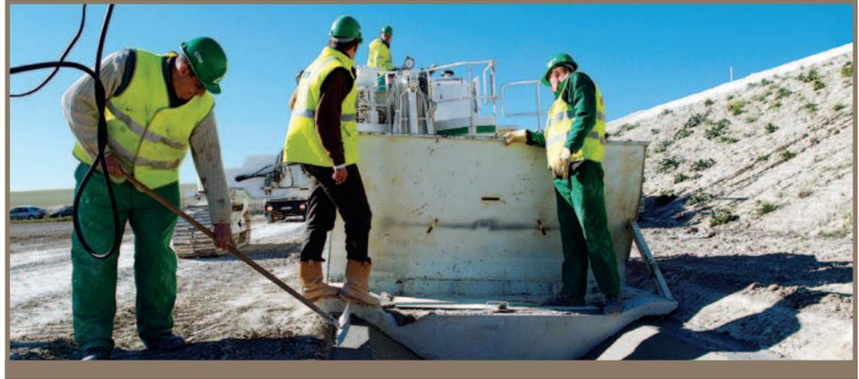
gene Verschalung gegossen. Dadurch erhält sie eine extrem glatte, wie glasiert wirkende Oberfläche.
