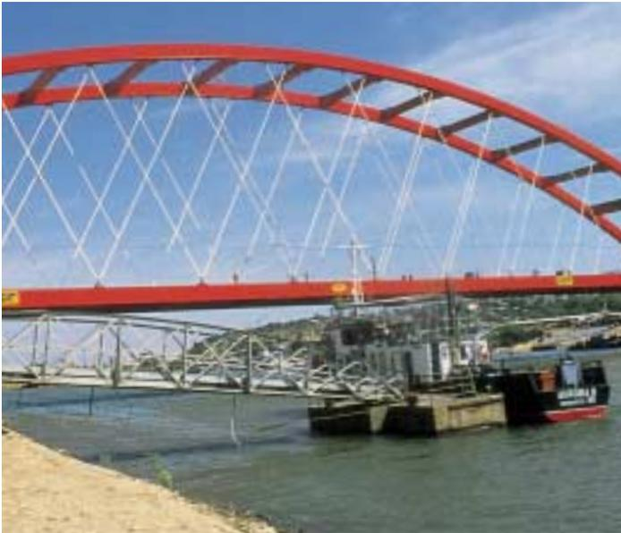
Um den Schiffsverkehr möglichst wenig zu behindern, wurde die Brückentafel der Metallbrücke in Cernavoda / Rumänien durch Drehen auf einem Flachkahn in die endgültige Position gebracht.
