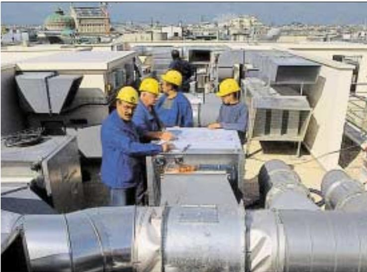
Installation der Klima- und Rauchabzugsanlage in einem der Bürobauten des AXA-Konzerns im 8. Pariser Arrondissement
