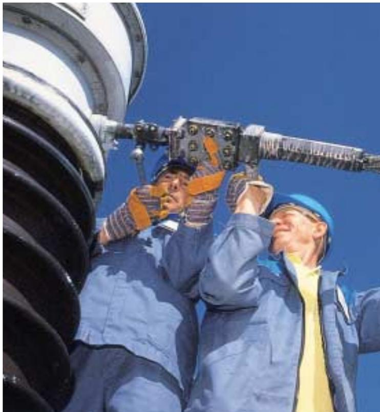
Erneuerungsarbeiten am 225 kV-Umspannwerk in Charenton im Auftrag von RTE (Réseau de Transport d'Electricité)
