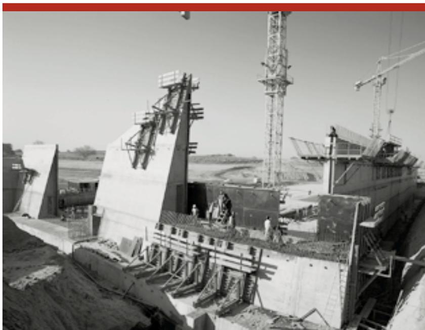
Construction d'un barrage en béton roulé compacté à Ziga, au Burkina.
