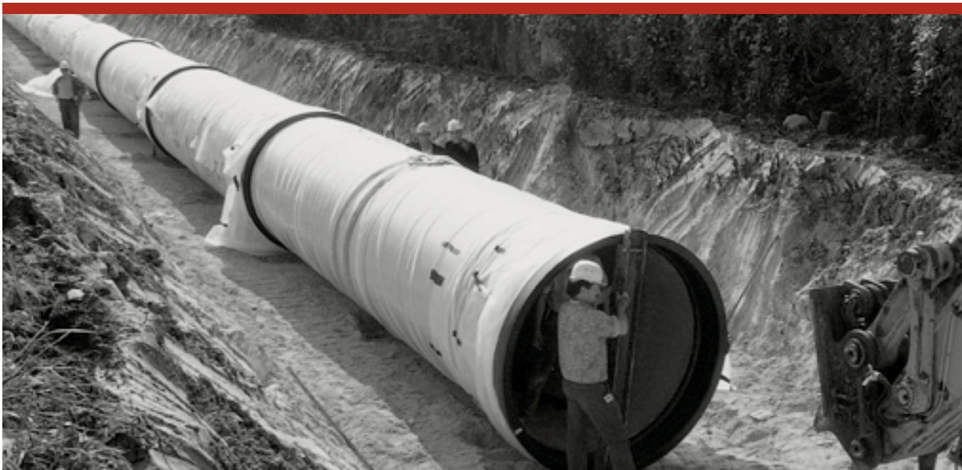
Pose de 250 mètres de conduites en fonte d'un diamètre de 1 800 millimètres dans le cadre de la reconstruction de l'aqueduc de l'Avre, à Auteuil-le-Roi, en Ile-de-France.
