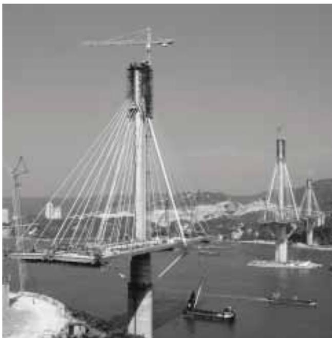
**Le pont à haubans de Ting Kau à Hong Kong est constitué de trois pylônes d'une hauteur respective de 167, 194 et 162 mètres et de deux travées centrales de 475 et 448 mètres.**
