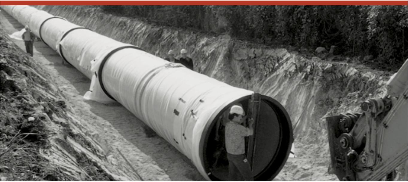
Verlegung von 250 m Gußrohrleitungen mit 1 800 mm Durchmesser im Rahmen des Neubaus der Avre-Trinkwasserleitung in Auteuil-le-Roi im Pariser Raum.
