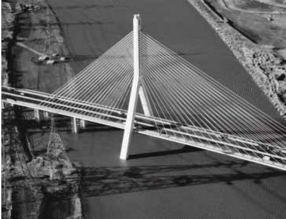
**Schrägseilbrücke über den Dee-Fluß im Norden von Wales. Mit 3,8 km Länge ist sie im Rahmen eines bedeutenden Straßenbauprojekts eine weitere Verbindung zwischen England und Wales.**
