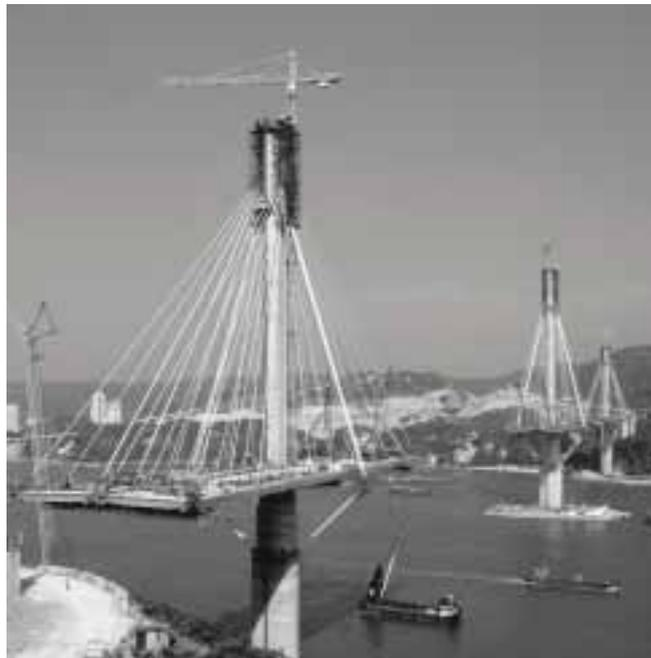
**Ting-Kau-Schrägseilbrücke** in Hongkong mit drei Pylonen mit 167, 194 bzw. 162 m Höhe und einer Mittelöffnung von 475 bzw. 448 Metern
