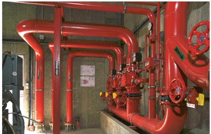
Sprinkleranlagen von Tunzini Protection Incendie für die Lagerhallen der Firma Schüco in Perray-en-Yvelines
