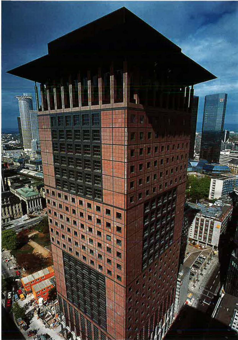
Heinrich Nickel stattete das Hochhaus des Japan Centers, das mitten im Geschäftsviertel von Frankfurt-am-Main gebaut wird, mit der Klimatechnik einrichtung aus.
