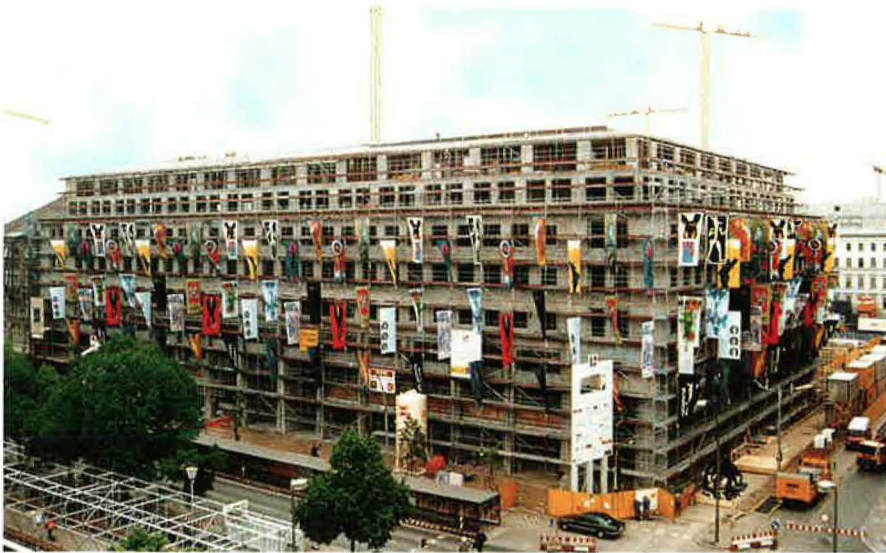
Der Bau des Lindencorso in Berlin-Mitte war 1995 die größte Baustelle der SGE Hoch- und Ingenieurbau. Der Beitrag mehrerer französischer und deutscher Künstler verlieh dem Richtfest einen besonderen Glanz.
