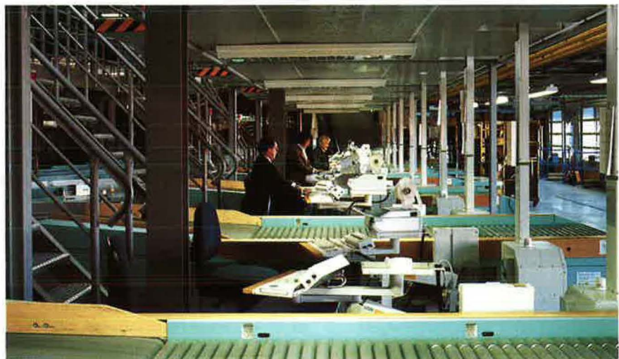
In ganz Deutschland wurden über 30 mit einem neuen Sortiersystem ausgestattete Frachtpostzentralen von G+H Montage mit Schallschutteinrichtungen ausgestattet.
