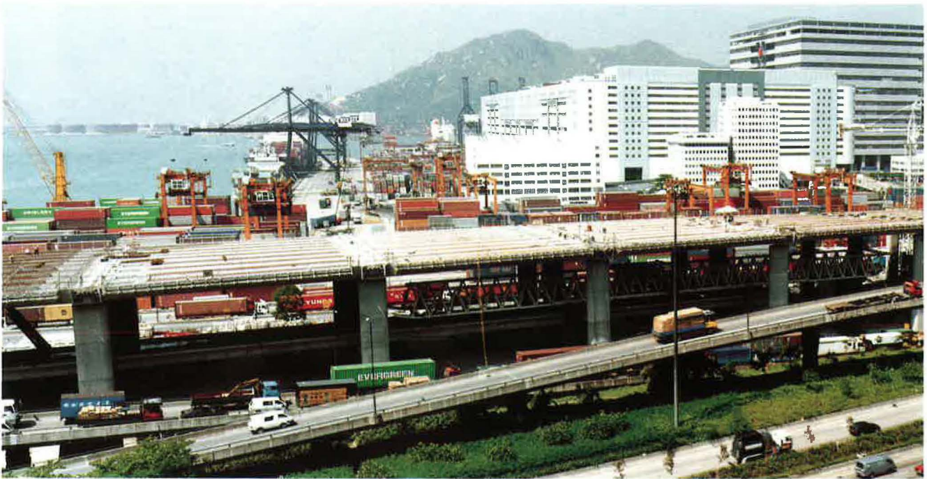
Das Viadukt von Kwai Chung ist eines der zentralen Elemente des Infrastrukturprogramms, das im Rahmen des Baus des neuen Flughafens von Hongkong realisiert wird. Die Errichtung des 3,5 km langen Viadukts, dessen Gesamtbrückendecke dreimal so groß wie die der Normandiebrücke wird, erfolgt direkt in der Stadt über mehreren Straßen- und Eisenbahnverkehrsachsen.
