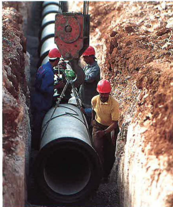
Ummantelungsarbeiten an Trinkwasserleitungen nördlich von Agadir (Marokko), die vom Staudamm von Dkhila gespeist werden.
