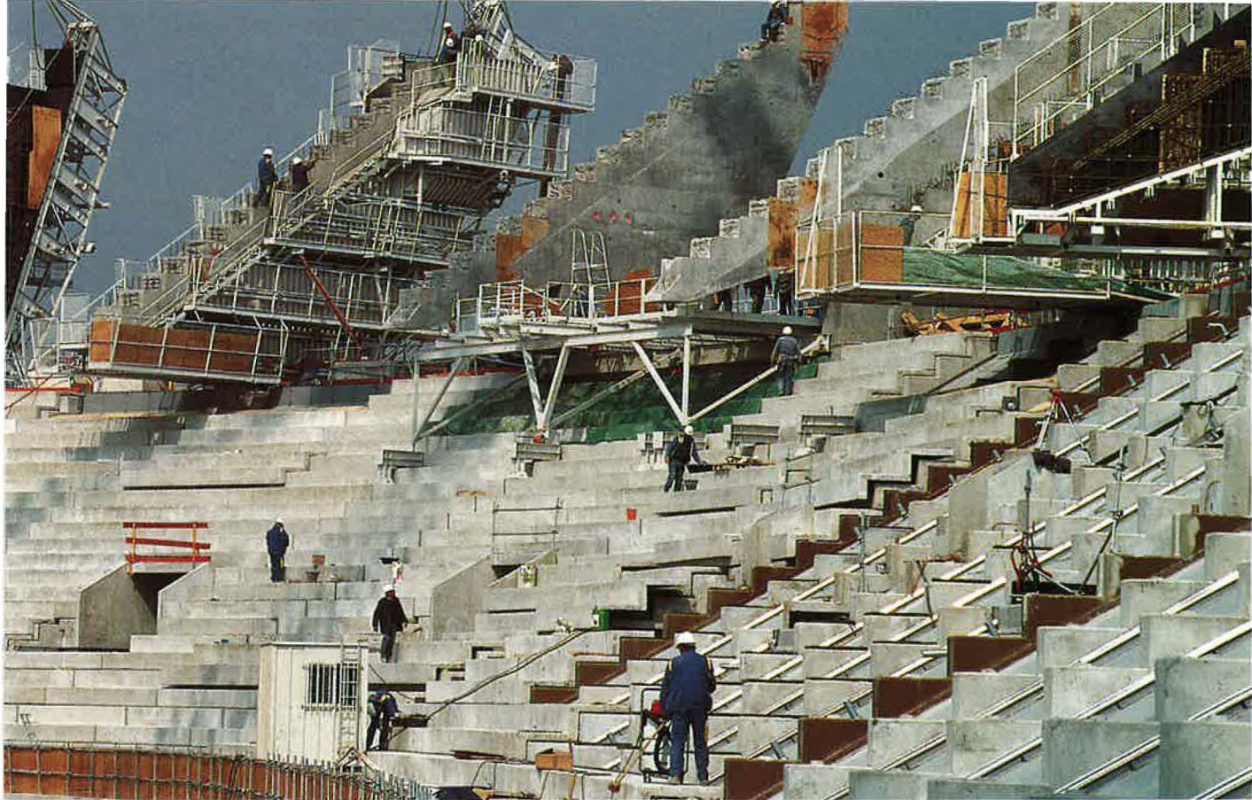
Der Grundstein des Stade de France wurde am 6. September 1995 gelegt. Sechs Monate später waren mehr als die Hälfte des Rohbaus errichtet, die Fundamente fertiggestellt und die Träger für die Sitzreihen angelegt.
