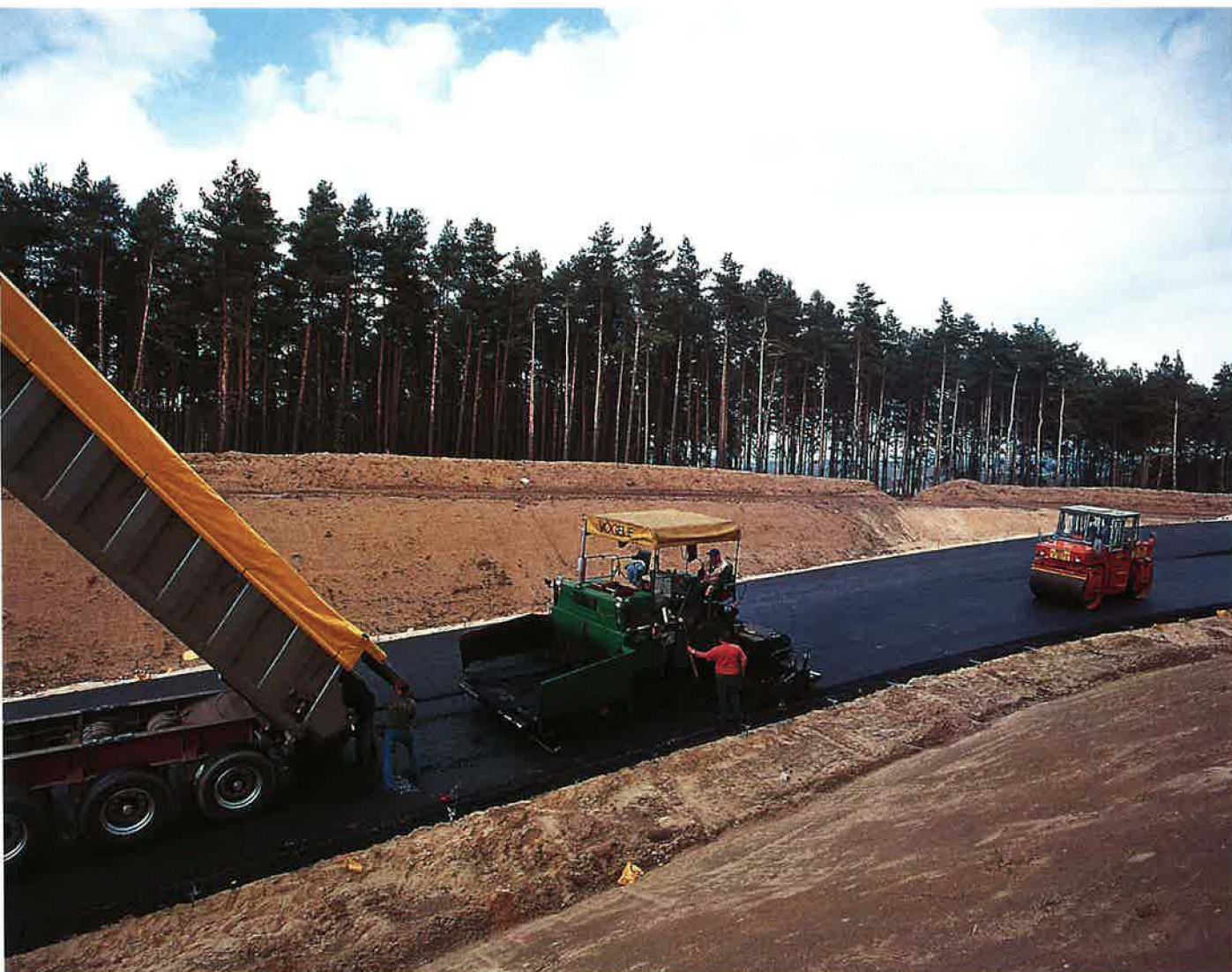
Réalisation par SGE VBU d'une bretelle d'accès à l'autoroute A2 (Berlin - Bochum) à la hauteur de la ville de Brandebourg.
