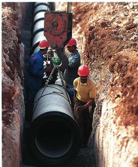
Travaux de renforcement du réseau de l'adduction d'eau qui alimente la ville d'Agadir au Maroc.
