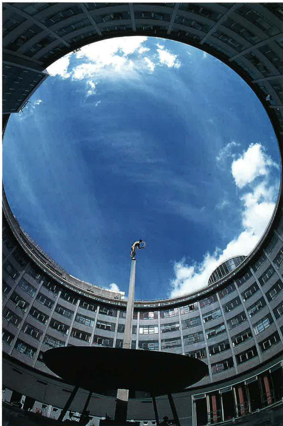
▼ C'est dans un ancien studio de télévision, situé dans l'ouest londonien, que Norwest Holst a aménagé le nouveau siège social de la BBC.
