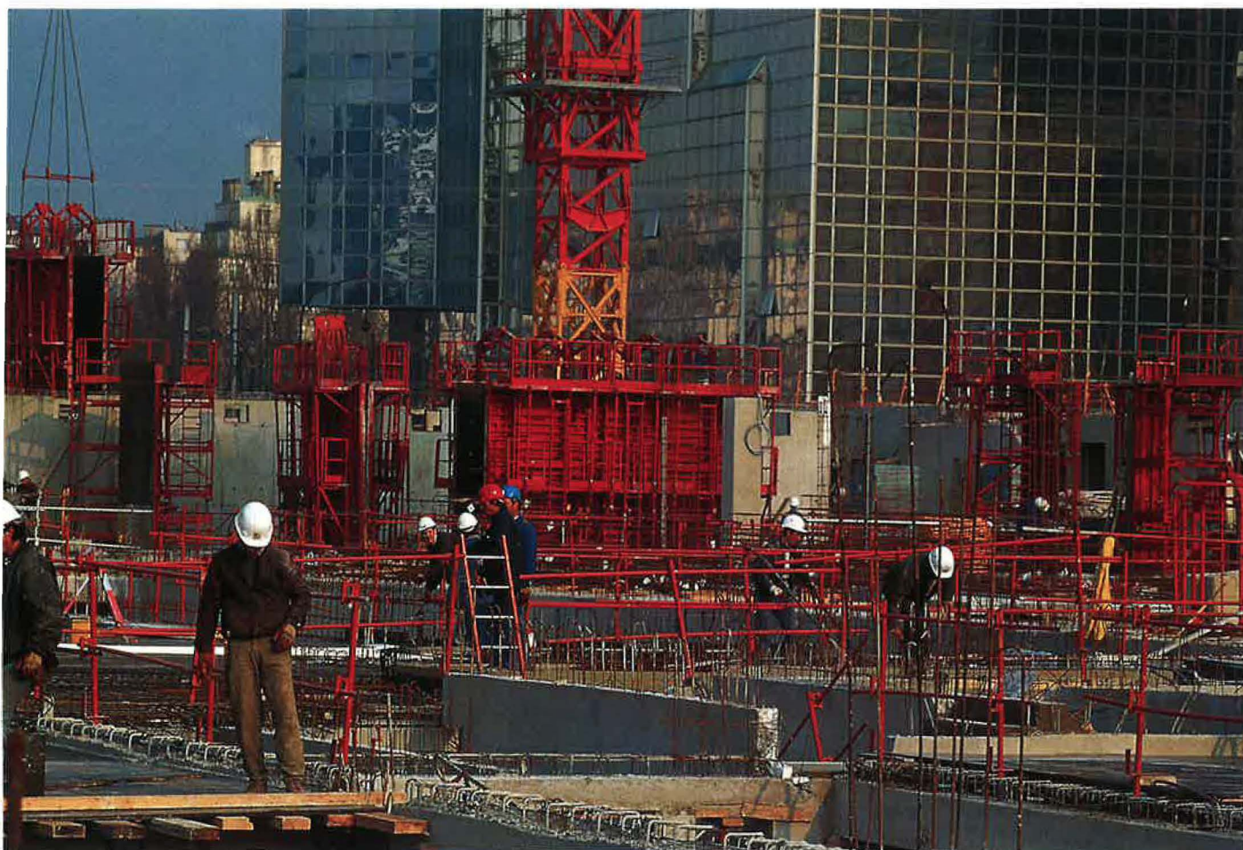
La construction de l'hôpital Georges Pompidou, dont Sogea réalise les travaux de gros-œuvre, a démarré en janvier 1995 sur le terrain des anciennes usines Citroën dans le 15 e arrondissement de Paris.
