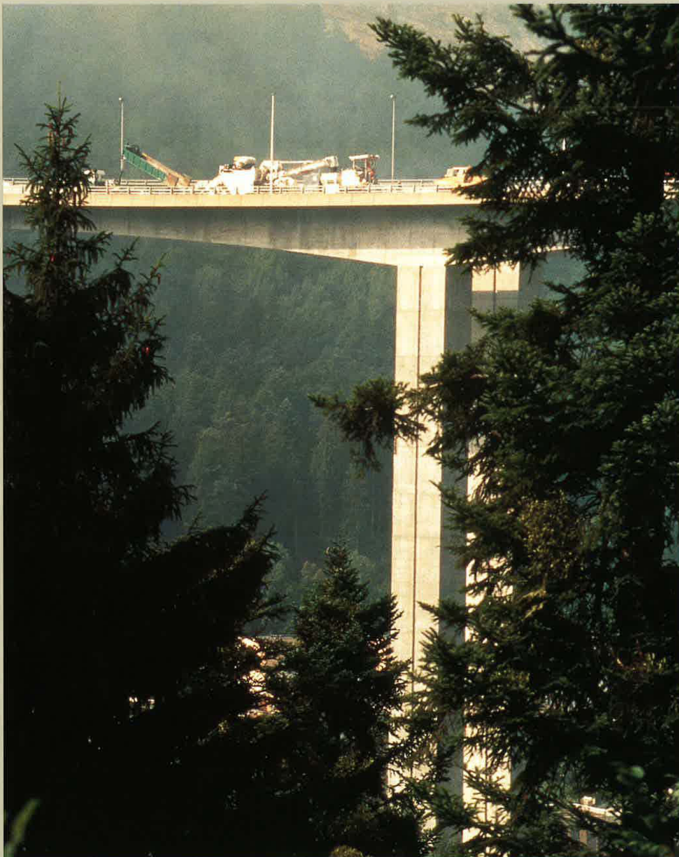
Viafrance a réalisé le revêtement des chaussées des nouveaux viaducs de Nantua et de Neyrolles sur l'autoroute A40 (Mâcon - Genève - Chamonix).
