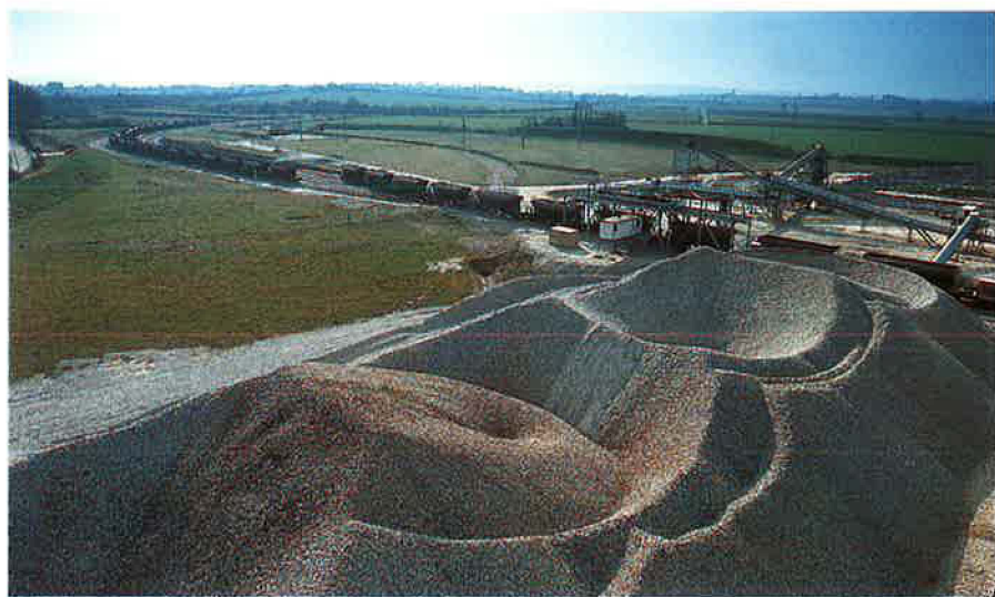
Acquises en 1989 par Viafrance, les carrières de Chailloué dans l'Orne ont doublé leur production de granulats pour l'approvisionnement du chantier de la future autoroute A29 (Le Havre - Yvetot).
