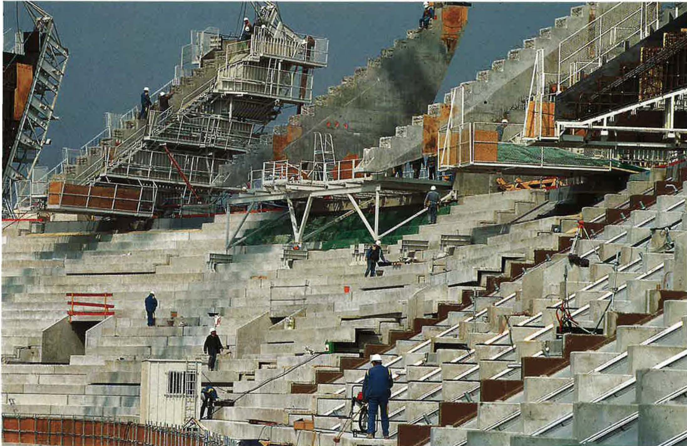
La première pierre du Stade de France a été posée le 6 septembre 1995. Six mois plus tard, plus de la moitié du gros œuvre était réalisée, les fondations achevées et les gradins intermédiaires mis en place.
