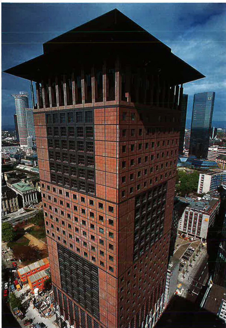
Heinrich Nickel a équipé en climatisation la tour du Japan Center, en cours de construction au cœur du quartier d'affaires de Francfort-sur-le-Main (Hesse).
