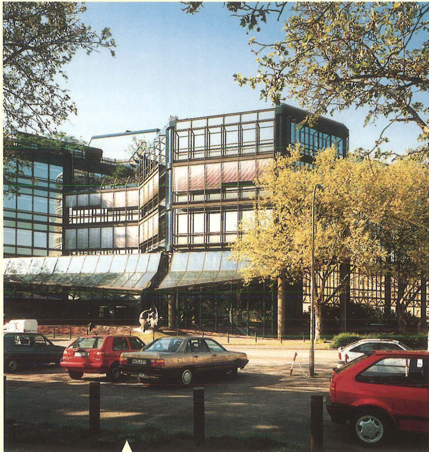
Le nouveau siège de la compagnie d'assurances ÖVA à Mannheim dont Klee a réalisé le gros œuvre.
