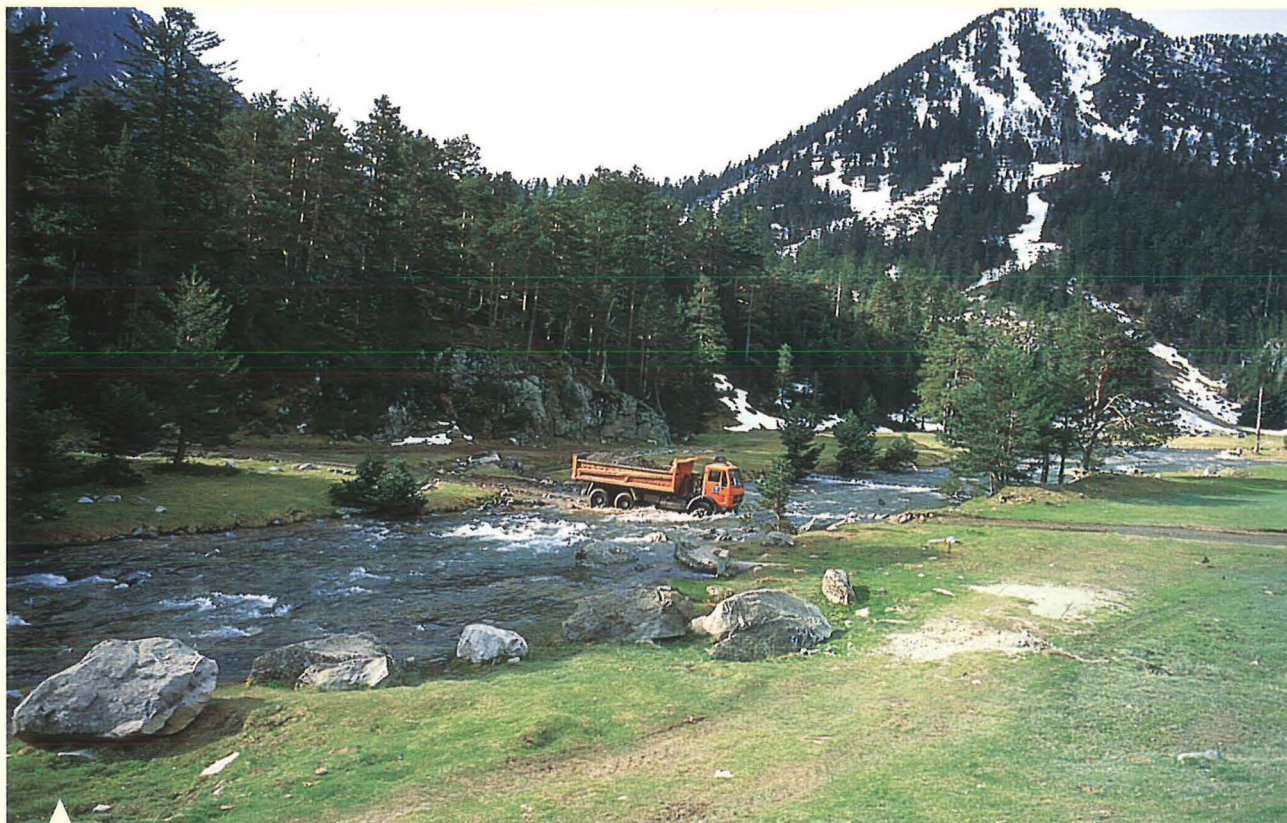
Aménagement du site du Pont d'Espagne au cœur du Parc National des Pyrénées.
