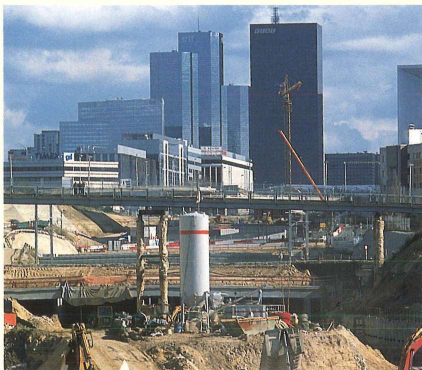
Sogea et sa filiale TPI Ile-de-France construisent, en tranchée couverte, le premier tronçon de l'autoroute A14 qui doit relier La Défense à l'autoroute de Normandie, à la hauteur d'Orgeval.
