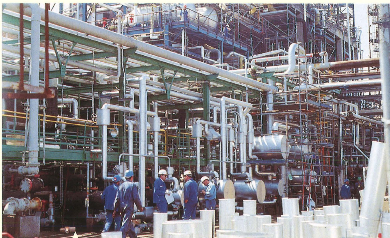
D'importants travaux d'isolation thermique et frigorifique ont été réalisés par Wanner sur la raffinerie BP à Dunkerque.
