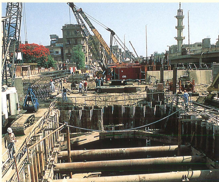
Travaux de franchissement du canal d'Ismailia pour la réalisation de la ligne 2 du métro du Caire.
