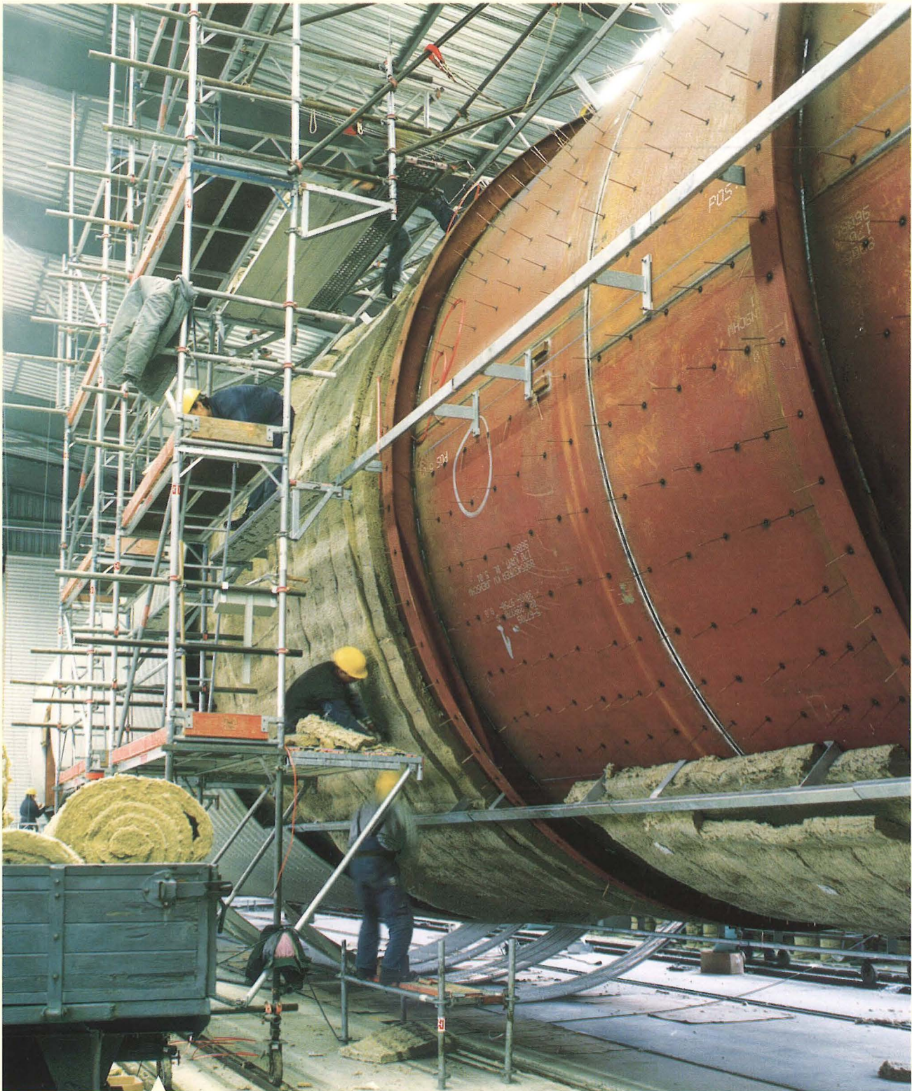
Travaux de pose de revêtement isolant à l'intérieur de la centrale thermique de Jämschwalde près de Dresde.
