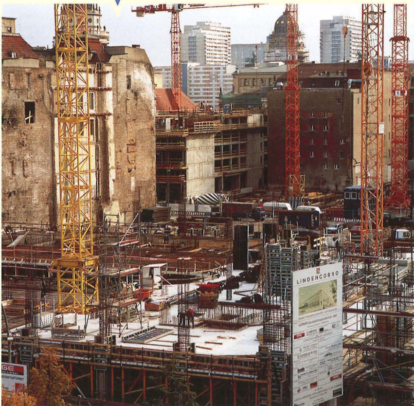
Travaux de gros œuvre du Lindencorso, à l'angle de l'avenue Unter den Linden et de la Friedrichstrasse à Berlin.
