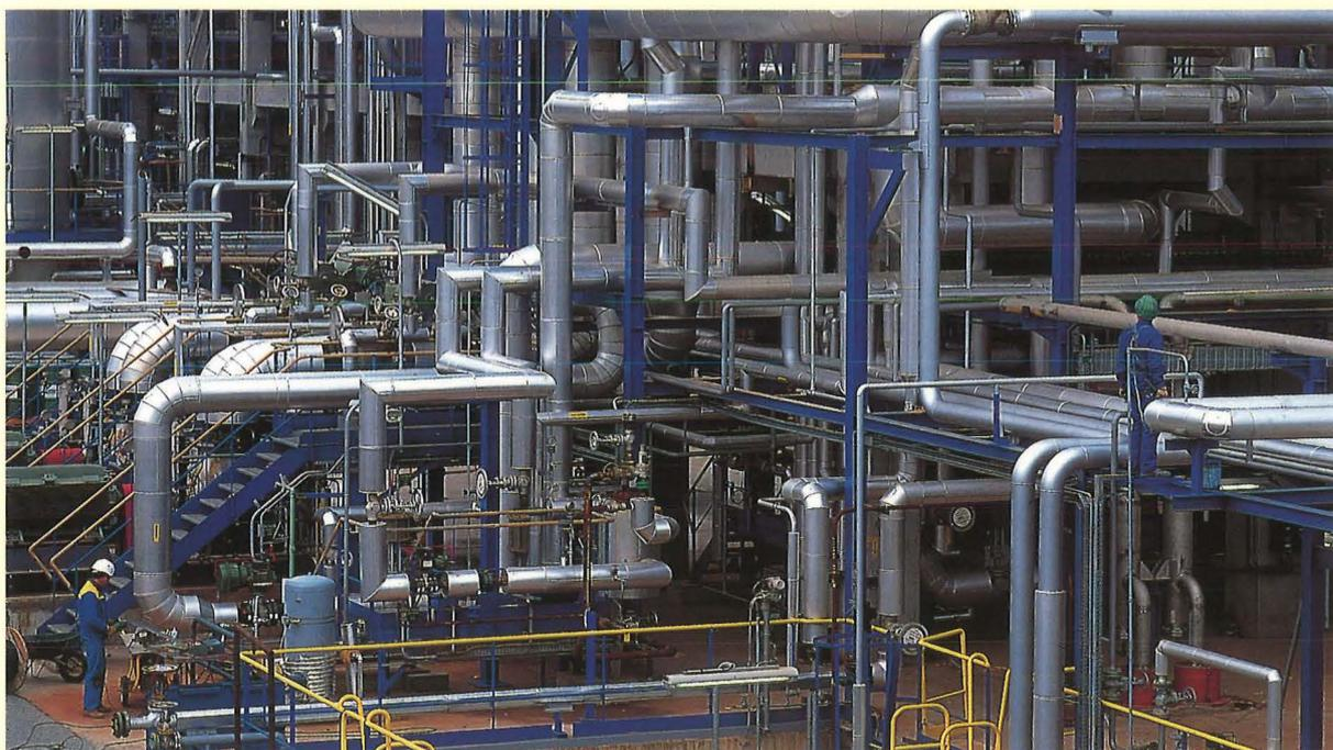
Wanner a réalisé l'isolation des tuyauteries et appareils de la raffinerie Elf - Antar de Donges en Loire-Atlantique. (Engineering : Technip).
