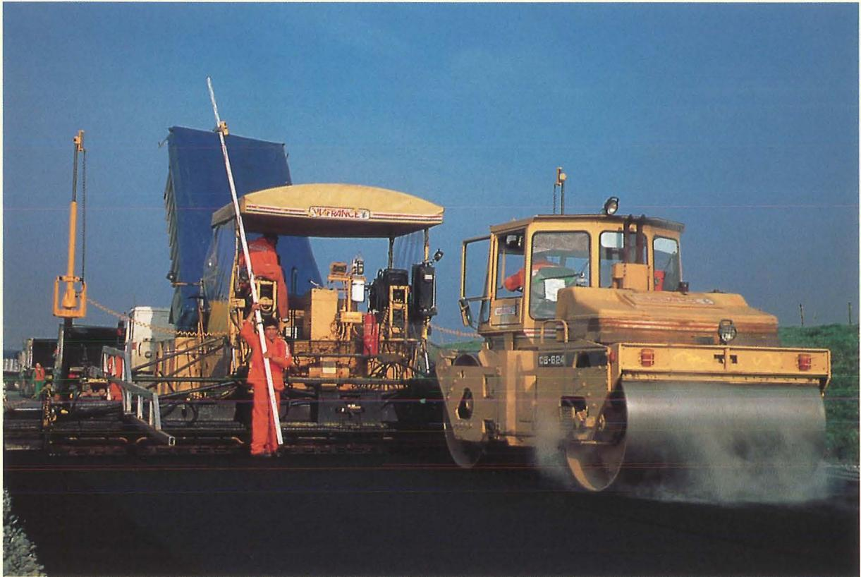
Pose de la couche de grave bitume sur le chantier de l'autoroute A 83 à partir d'un finisseur guidé par laser.
