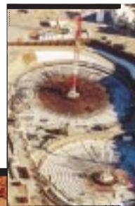
Entre Rion et Antirion en Grèce, le pont piloté par DUMÉZ-GTM mesurera 3 km. Première étape, les 2 premières embases de 90 m de diamètre et de 13 m de haut en cours de construction à terre, remorquées une fois achevées vers leur emplacement définitif et posées au fond de la mer pour recevoir les piles du pont.
