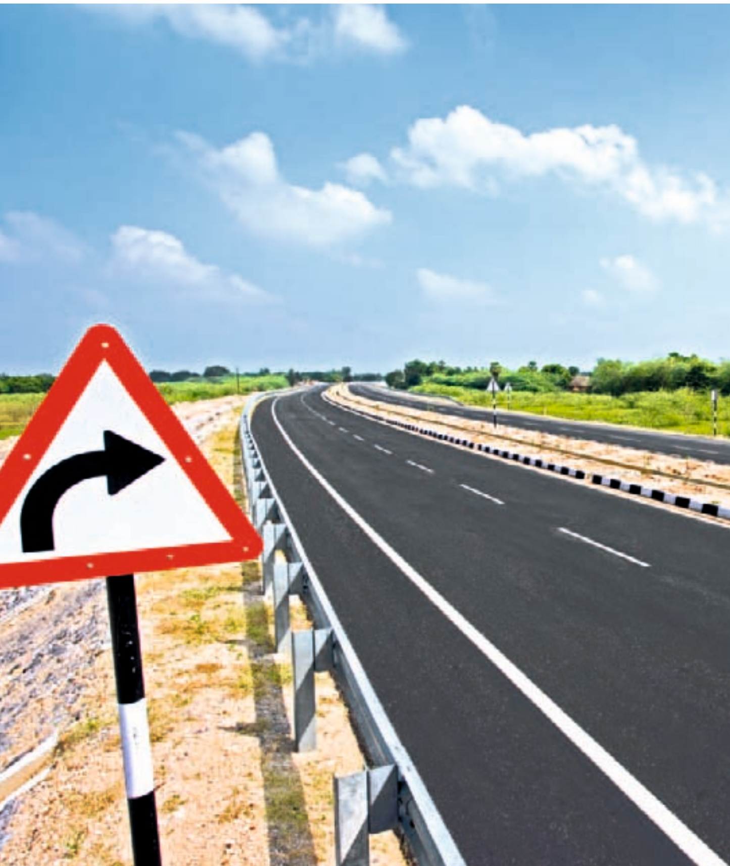
Construction routière réalisée par NAPC aux environs de Chennai (Inde).
