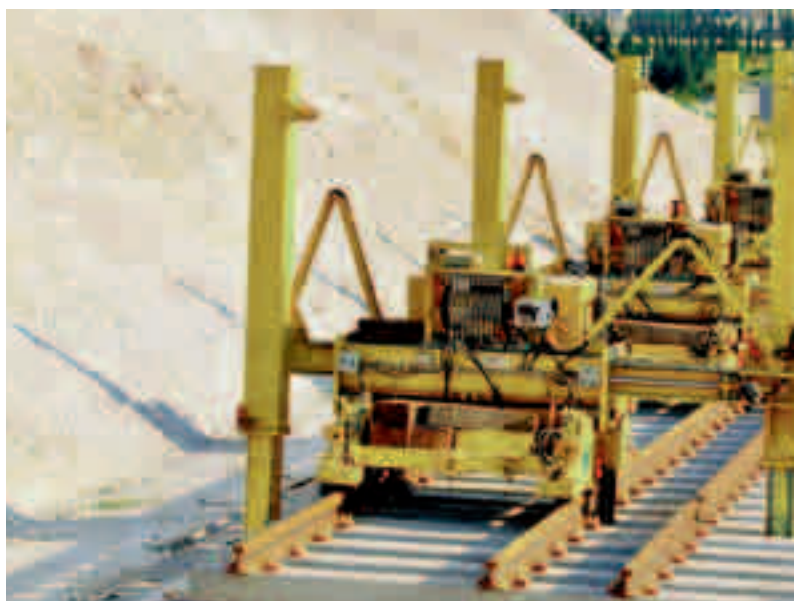
Rénovation de voies ferrées par ETF-Eurovia Travaux Ferroviaires (France).
