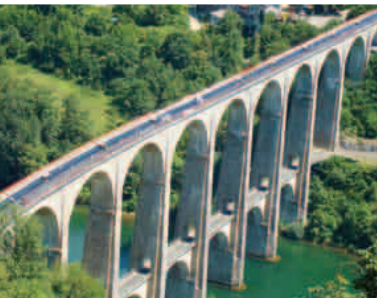
Étanchéités sur le viaduc de Cize-Bolozon dans l'Ain (France).
