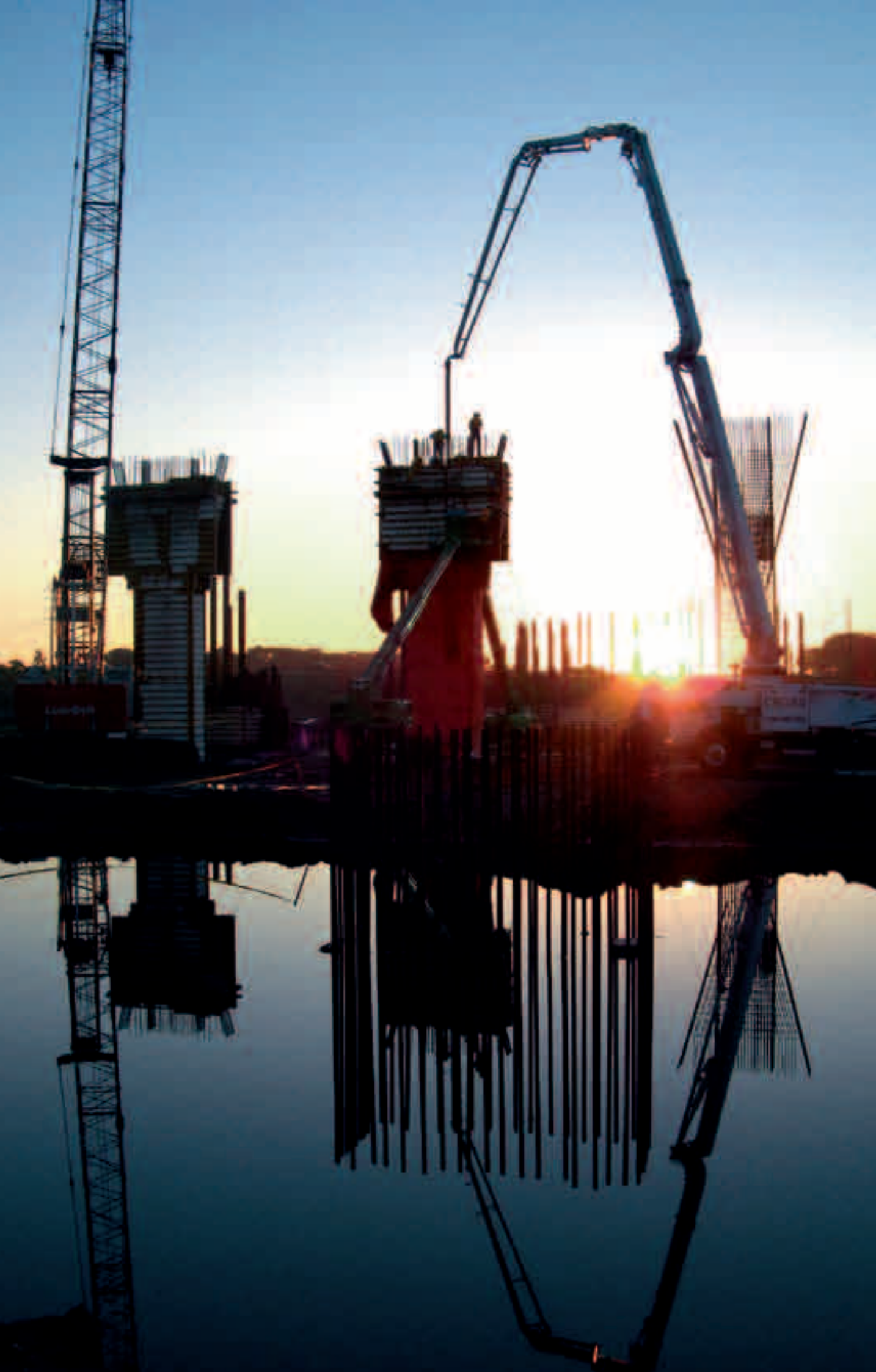
Prolongement du boulevard Maitland, près d'Orlando (États-Unis).
