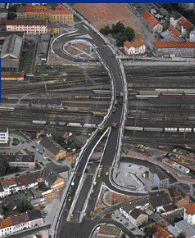
^ Réalisation d'une section de 9,2 km sur l'autoroute D5 reliant Prague à Munich, pour contourner la ville de Plzen (République Tchèque).
