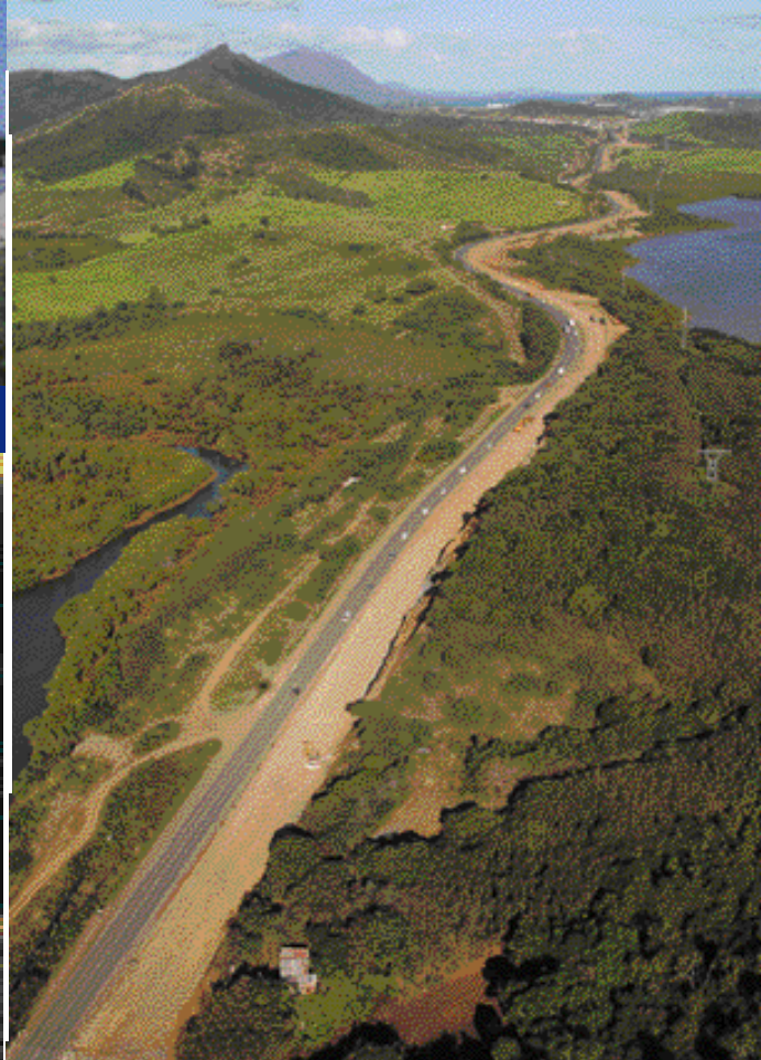
^ Doublement de la voie express au nord de Nouméa (Nouvelle-Calédonie).
