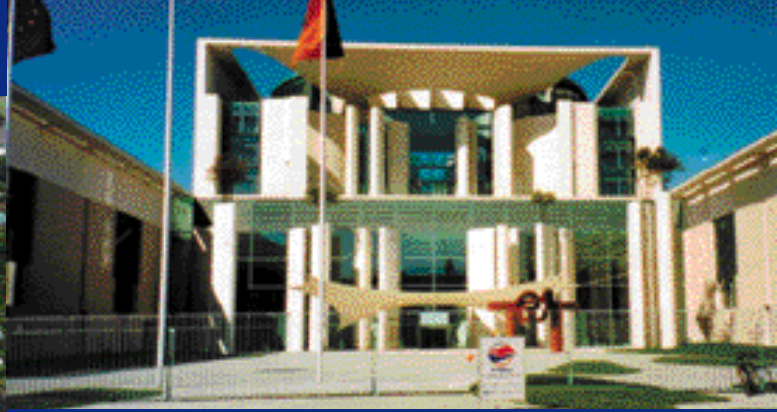
^ Réalisation du chantier de la Willy-Brandt-Straße et de la zone piétonne devant la nouvelle chancellerie à Berlin (Allemagne).
