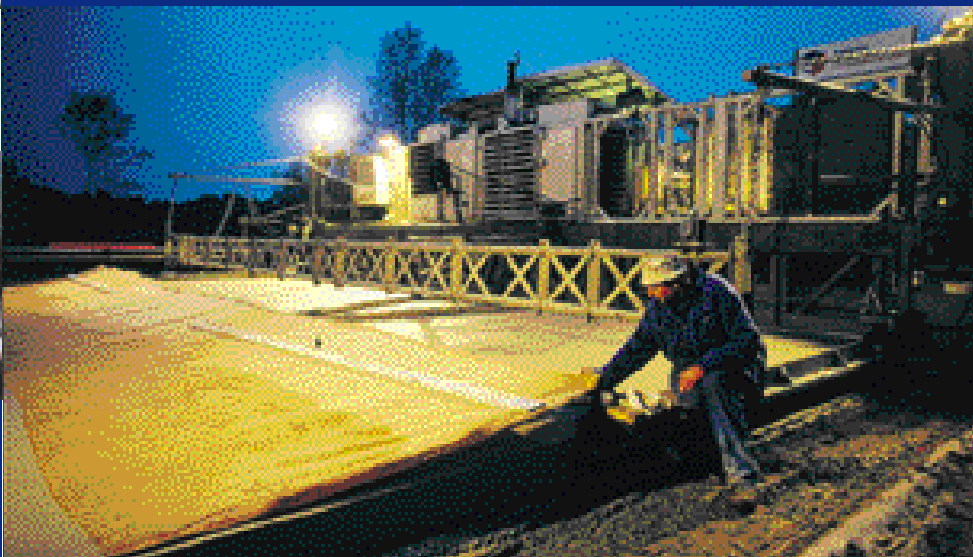
^ Réhabilitation de la chaussée béton d'une route 2 x 2 voies à Hanovre (Allemagne).
