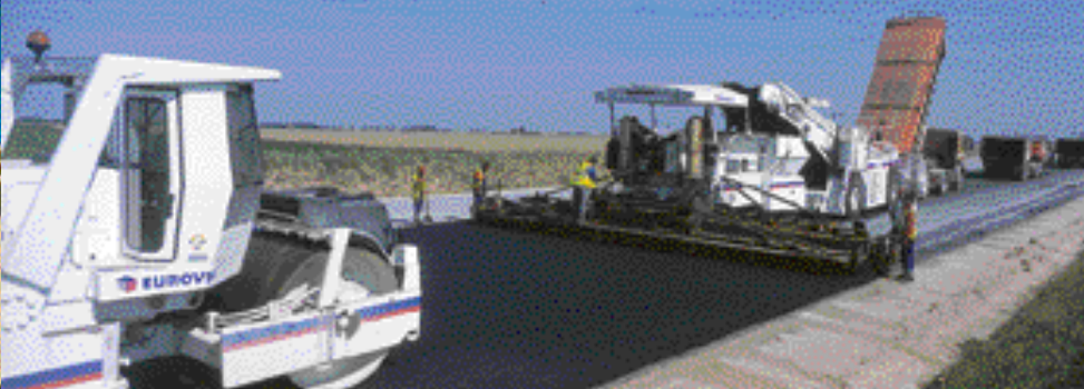
^ Construction de la déviation de Laversines (France).
