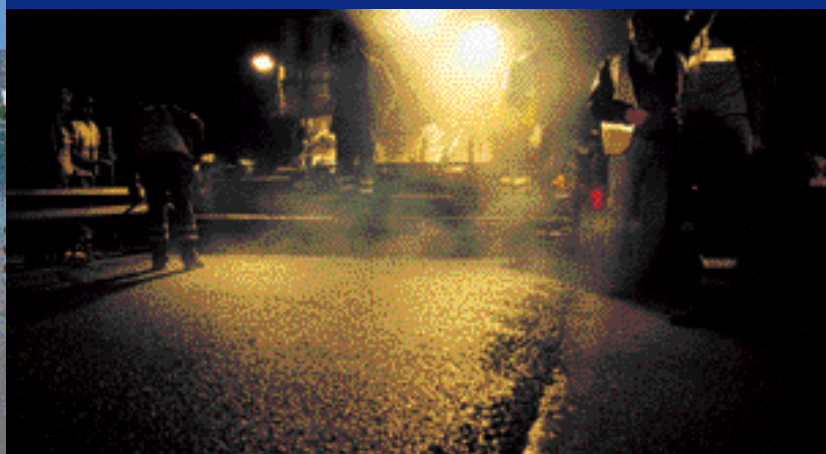
∨ Rechargement des chaussées de l'A13 entre Rocquencourt et Orgeval (France).
