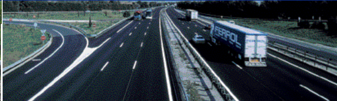
∨ Réfection avec l'enrobé drainant Drainovia® de la chaussée de l'A501 (France).
