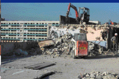
^ Démolition de la barre Gérard-Philippe à Gennevilliers avec une pelle de grande hauteur (France).
