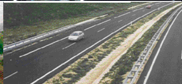
^ Entretien intégral de l'autoroute Jerez-Los Barrios en Andalousie pour une durée de deux ans (Espagne).
