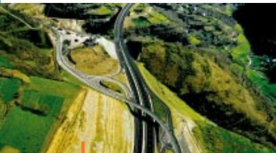
1 - Espagne Construction de la route nationale 6 (section Puerto Piedrafita).
