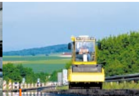
3 - Allemagne Réalisation en partenariat avec Bomag d'un chantier expérimental de mesure du compactage en temps réel sur une section de 6 km de l'autoroute A45 à Francfort.
