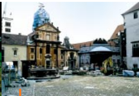
2 - République Tchèque Rénovation des voiries du Château de Prague.
