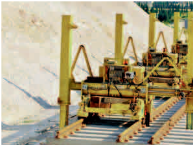
Sanierung von Schienenwegen durch ETF-Eurovia Travaux Ferroviaires (Frankreich)
