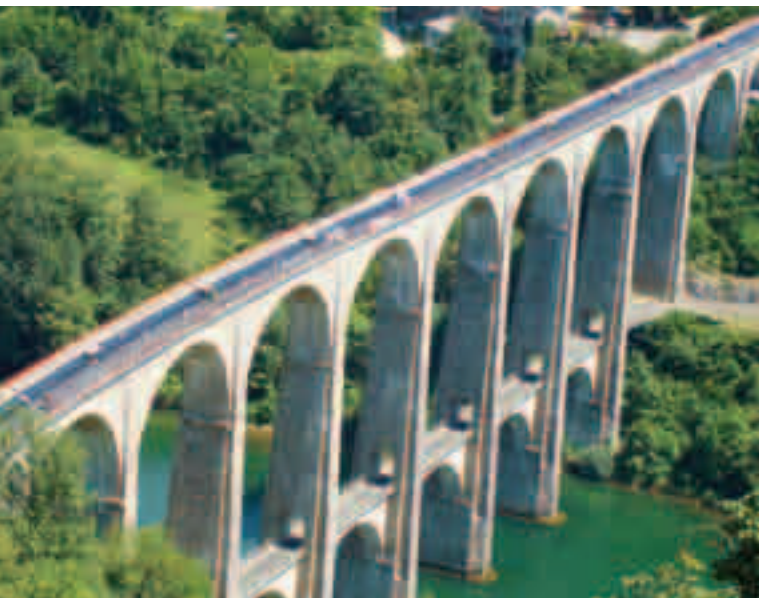
Abdichtungsarbeiten an der Cize-Bolozon-Hochbrücke im Département Ain (Frankreich)
