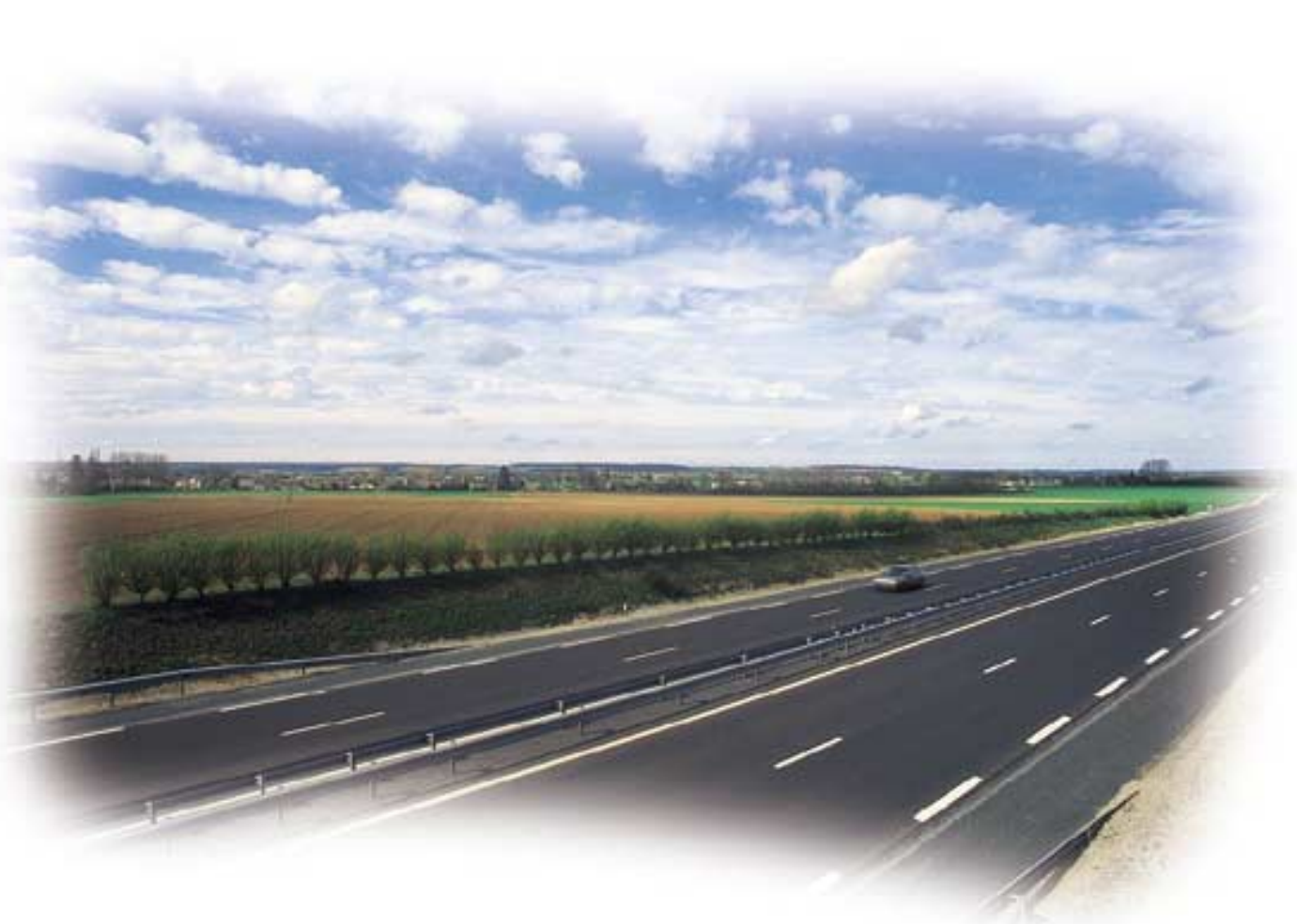
Autoroute A20 / A20 motorway EJL Sud-Ouest
