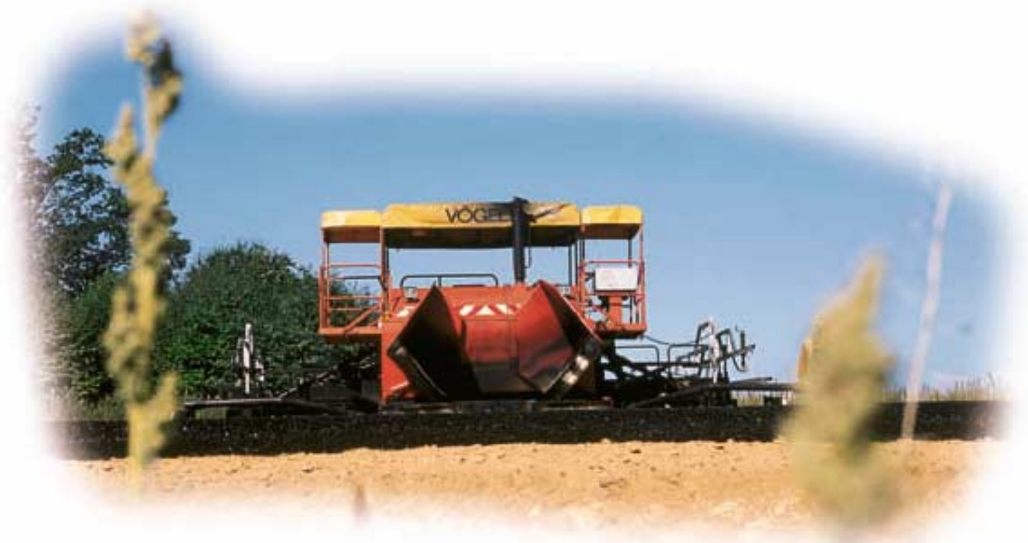
Jonction A11 - A28 / A11 - A28 junction Le Mans (Sarthe) EJL Centre-Pays de Loire
