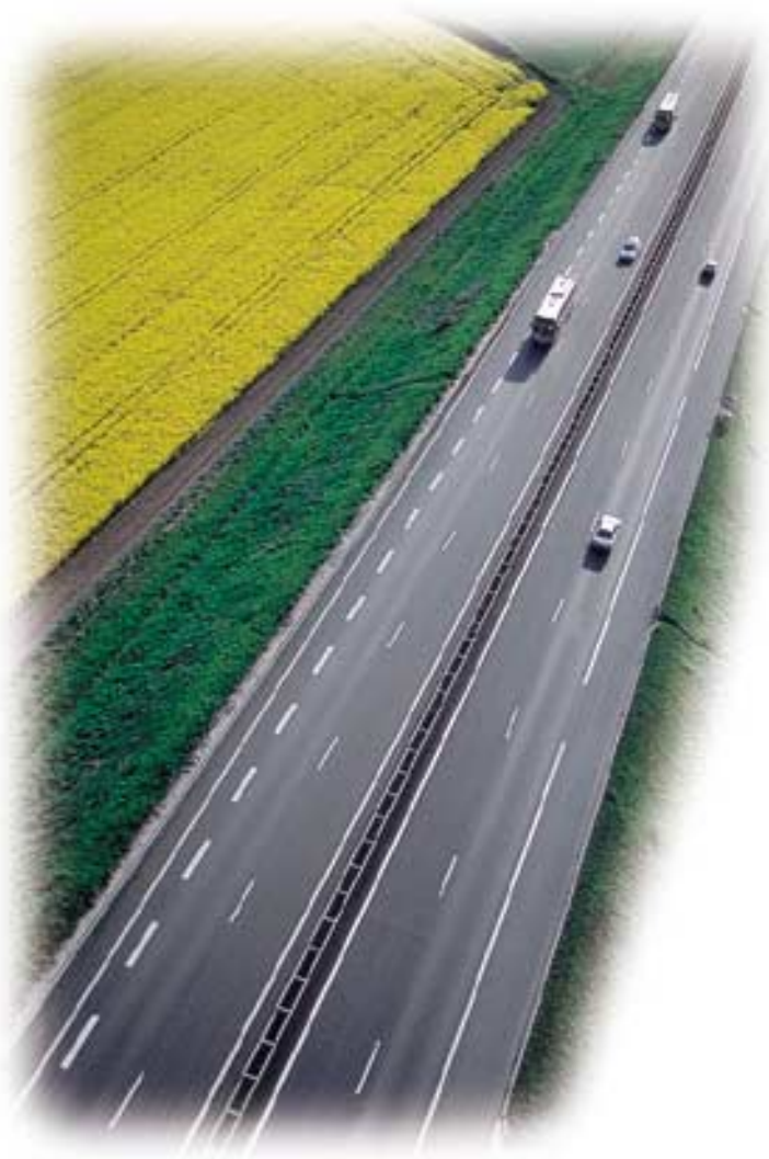
Autoroute A10 / A10 motorway Gironde EJL Sud-Ouest
