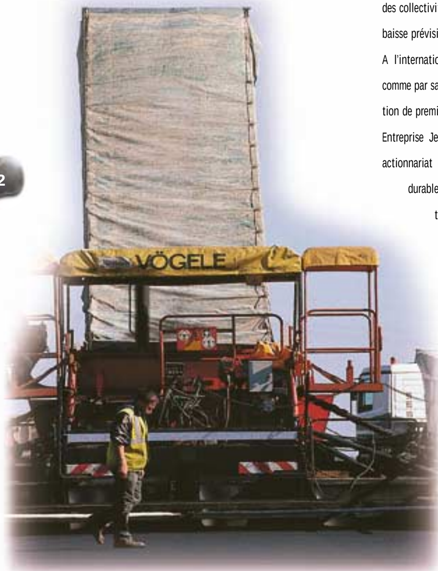
Autoroute A28 / A28 motorway Le Mans EJL Centre-Pays de Loire
