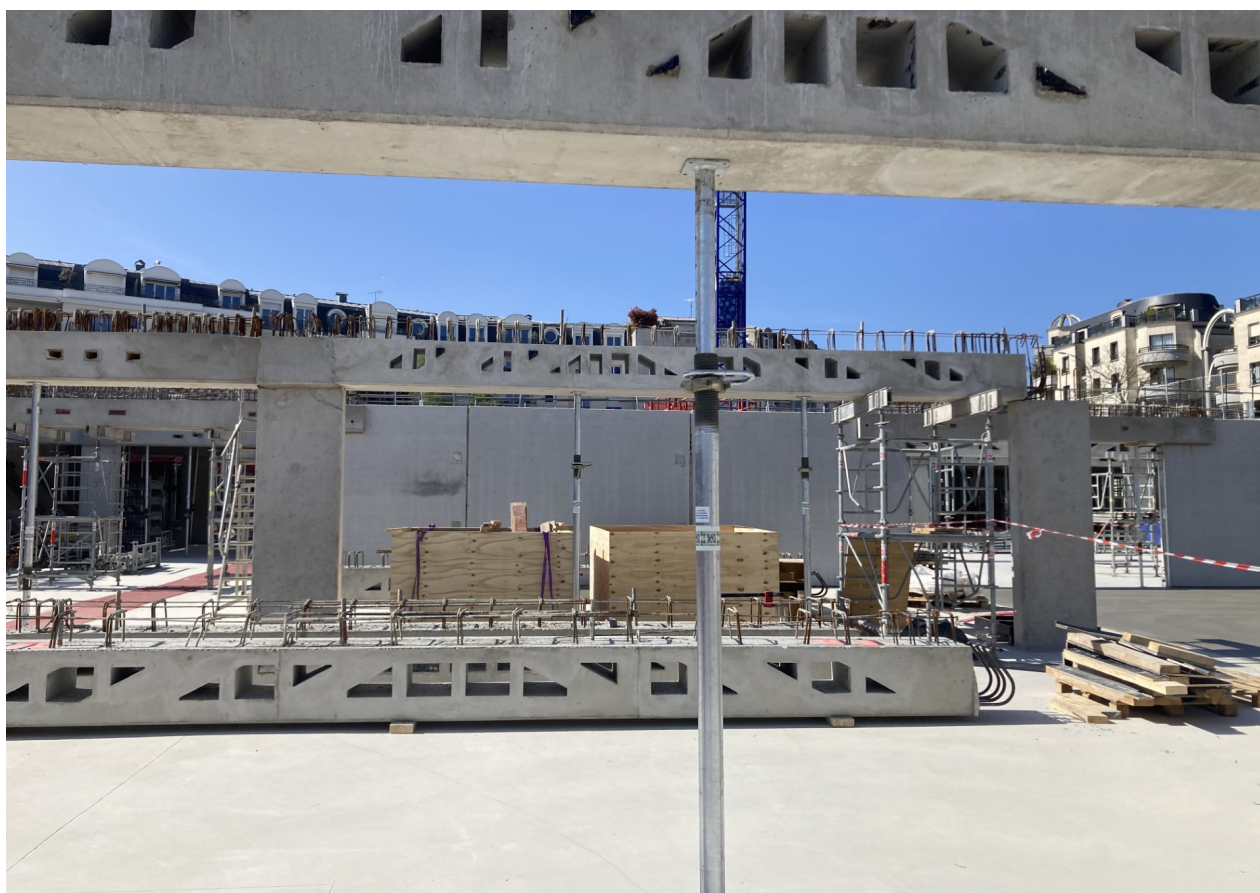
Les Halles de marché de Nogent-sur-Marne (Val-de-Marne). Au second plan, des optipoutres.
