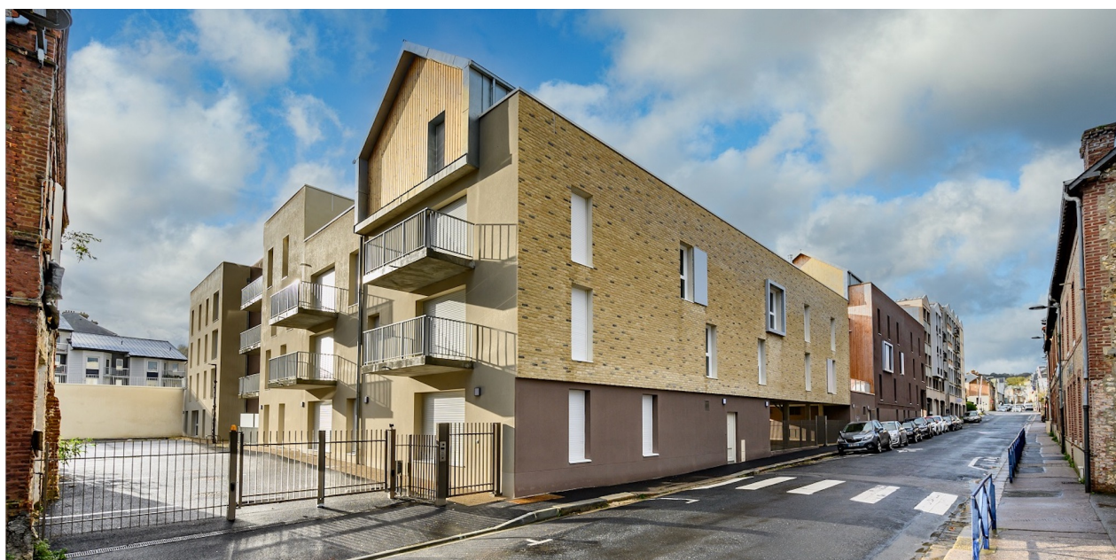
Résidence intergénérationnelle à Fécamp.
