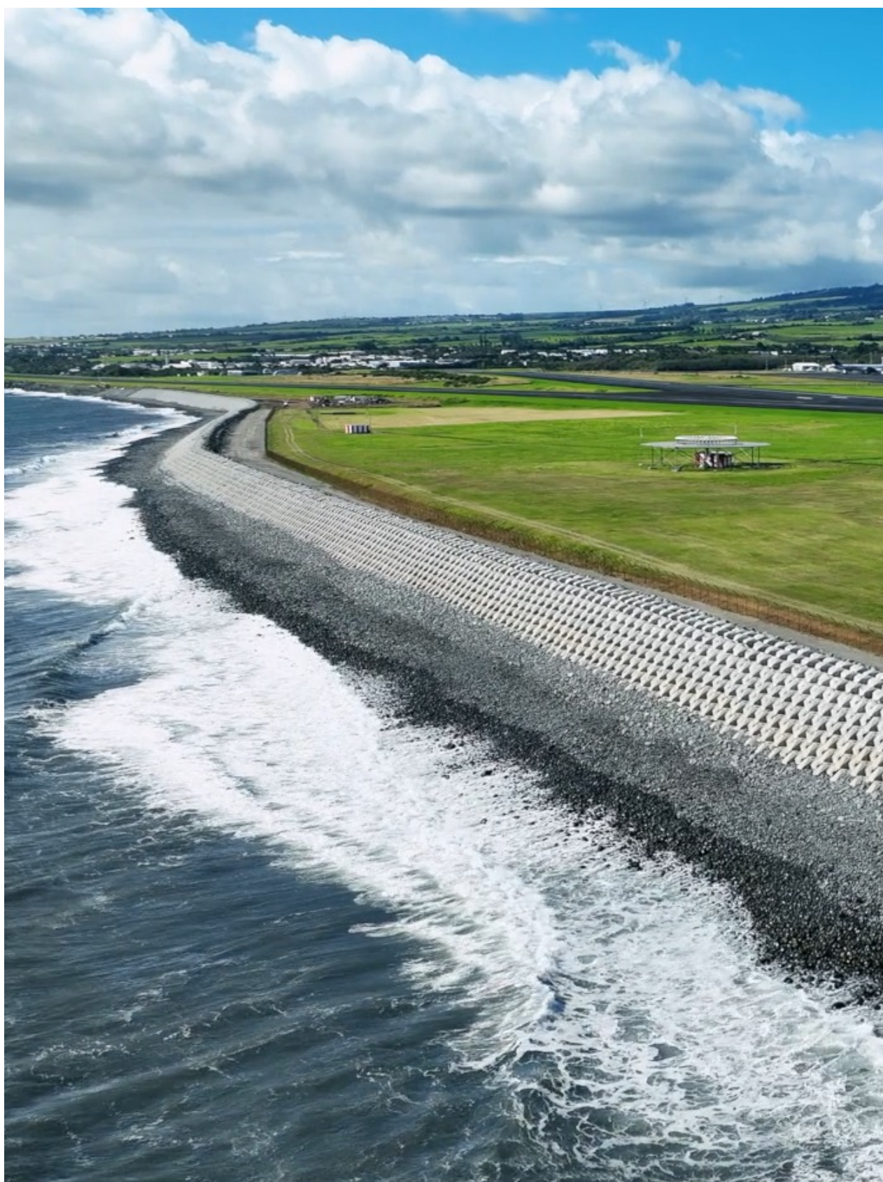
Digue de protection du littoral de l'aéroport de La Réunion. Un exemple d'infrastructure écoconçue avec moitié moins de béton utilisé, soit 21 000 m 3 de béton évité.
