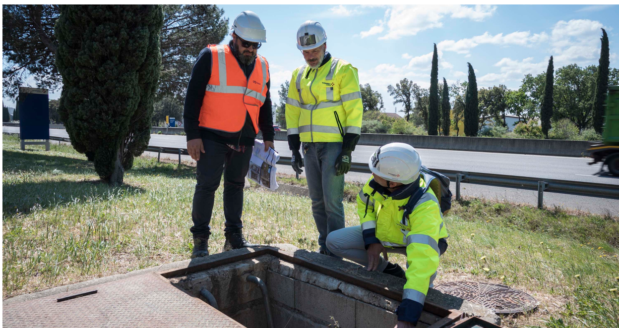
Installation de compteurs d'eau connectés sur le réseau VINCI Autoroutes.
