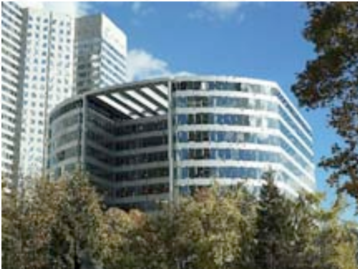
Equipment of property complexes (La Défense Plaza)
