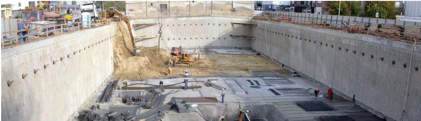
SPAIN - Valencia - Corte Inglés - Diaphragm wall 54m deep
