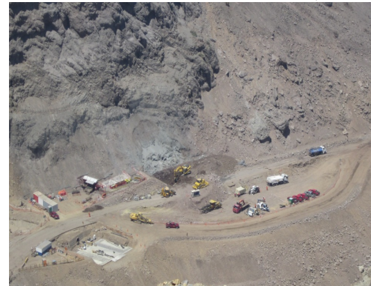
El Teniente mine tunnels, Chile
