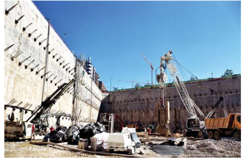
SPAIN - Valencia - Corte Inglés - Diaphragm wall 54m deep
