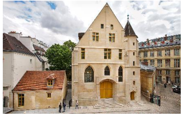
Restructuration du Couvent des Cordeliers - Paris 6 ème © L'Image Contemporaine
