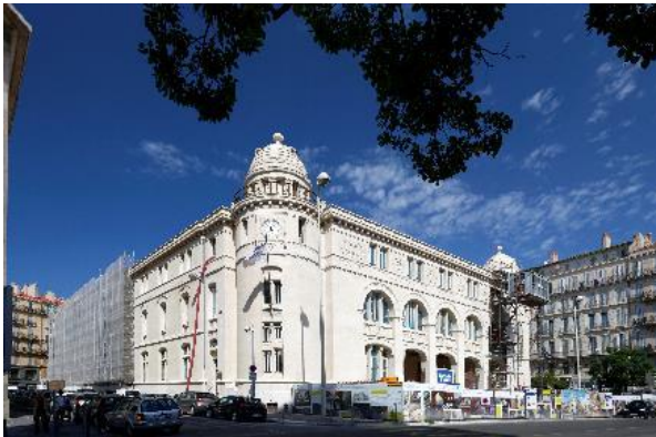
Restructuration de la Poste Colbert - Marseille (13) © Jérôme Cabanel
