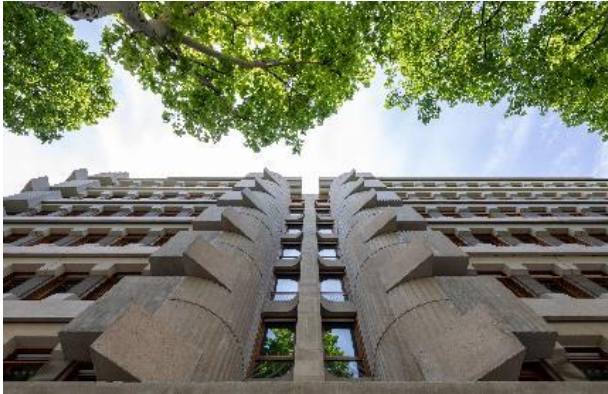
Réhabilitation du 58-66 rue de Mouzaïa - Paris 19 ème © Pierre L'Excellent
