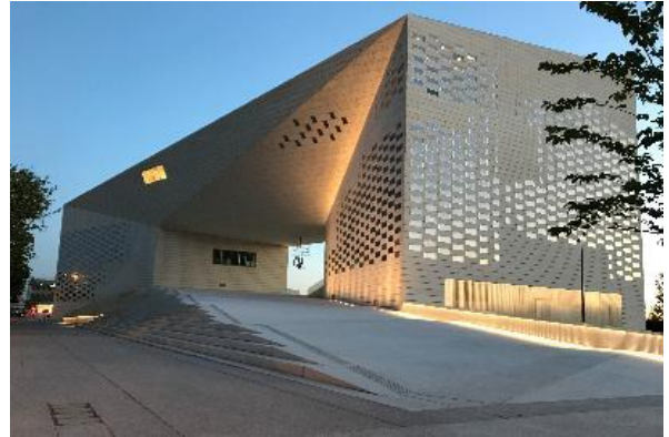
Réalisation de la MECA - Bordeaux (33) © VINCI Construction France
