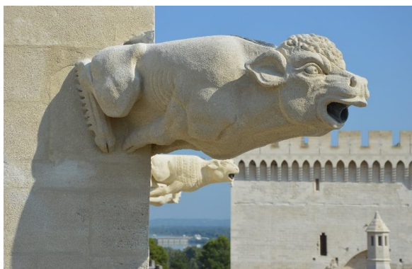
Restauration des tours des Anges et de la Garde-Robe du Palais des Papes à Avignon (84) - © DR VINCI Construction France
