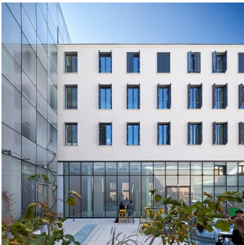
Restructuration du 8-10 rue Charles V (Paris 4 ème ) © Eddy Vahanian, Architecte DPLG
