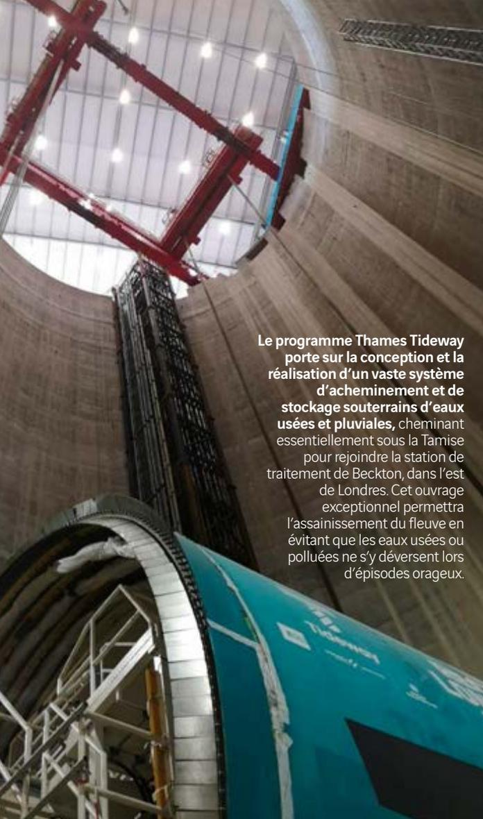
**Le programme Thames Tideway porte sur la conception et la réalisation d'un vaste système d'acheminement et de stockage souterrains d'eaux usées et pluviales**, cheminant essentiellement sous la Tamise pour rejoindre la station de traitement de Beckton, dans l'est de Londres. Cet ouvrage exceptionnel permettra l'assainissement du fleuve en évitant que les eaux usées ou polluées ne s'y déversent lors d'épisodes orageux.
