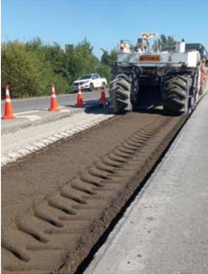
← **Au Chili, premier chantier de réhabilitation** d'une route à l'aide d'une technique de recyclage en place au ciment.
