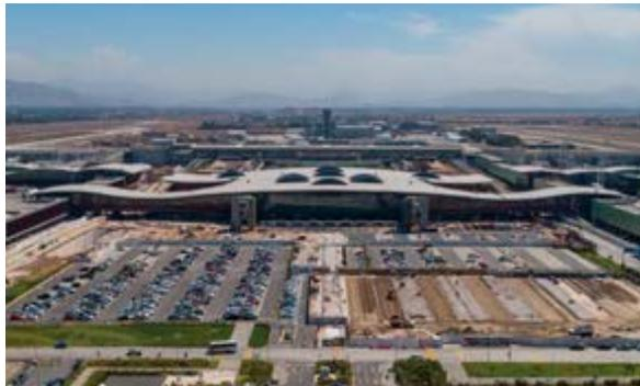
Dans le cadre de l'agrandissement de l'aéroport de Santiago pour VINCI Airports et ADP, cinq terminaux d'une surface de 250 000 m<sup>2</sup> ont été conçus et construits par VINCI Construction, afin de permettre le doublement de la capacité d'accueil de l'aéroport actuel, qui passera ainsi de 15 à 30 millions de passagers.
