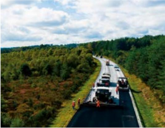
↑ La section Tulle-Est/Égletons de l'A89 (VINCI Autoroutes) a fait l'objet de travaux d'entretien de chaussées. Afin de réduire l'impact environnemental du chantier, les enrobés mis en œuvre atteignent un très fort taux de recyclage (70 %), obtenu grâce à une usine d'enrobés mobile unique au monde.
