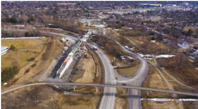
← Pour réaliser l'extension de son réseau de train léger O-Train, Ottawa a confié à VINCI Construction et ses partenaires la conception-construction et le financement de plus de 27 km d'infrastructures comportant quatre kilomètres en tranchée couverte, 20 ouvrages d'art, 16 stations, un centre de maintenance et tous les systèmes associés. Les travaux comportent également des élargissements autoroutiers sous trafic sur 12 km.
