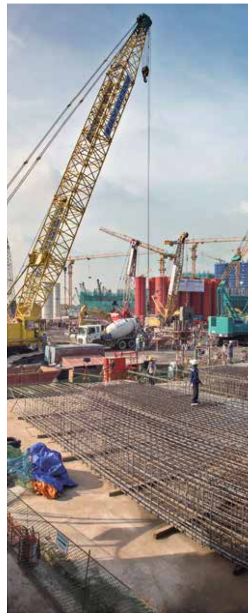
1 – Travaux de fondations de la tour Landmark (81 étages) à Hô Chi Minh-Ville au Vietnam.
