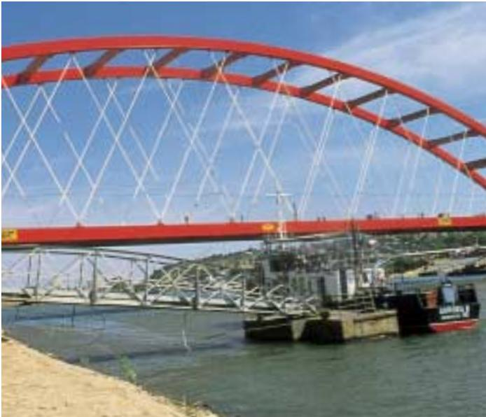
Le tablier du pont métallique de Cernavoda, en Roumanie, a été mis en place par rotation sur barge, technique qui a permis de limiter l'interruption de la navigation.
