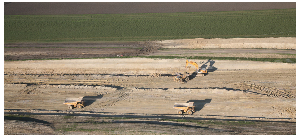
Début des travaux de l'A19 au T1 2007
