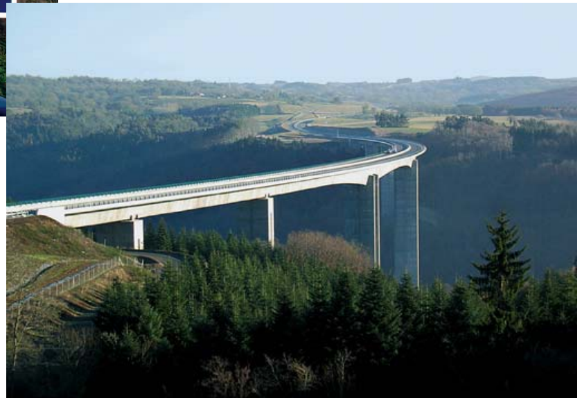
Sioule viaduct (A89)
